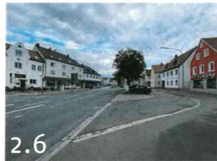
Neugestaltung Seitenbereiche Bahnhofstraße - Freyung - Untere Vorstadt (B15)
