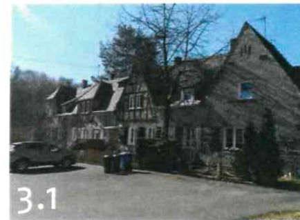
Umbau und Sanierung „Glaserer Häuser“ am Hofgartenweg
