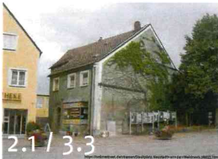
Rückbau / Neubau „Stadtplatz 43“
